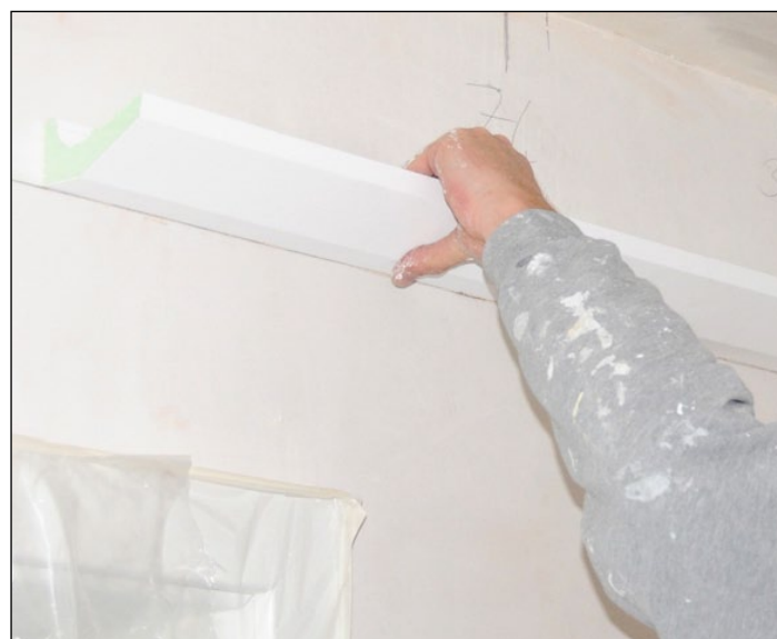
Profil an der gewünschten Stelle an der Wand anbringen, fest drücken Anschließend eventuelle Lücken zuspachteln, Wand und Profil ggf. streichen
