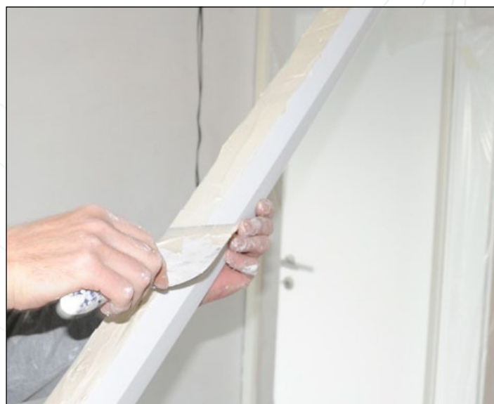
die Rückseite des Profils mit Stuckkleber einspachteln
